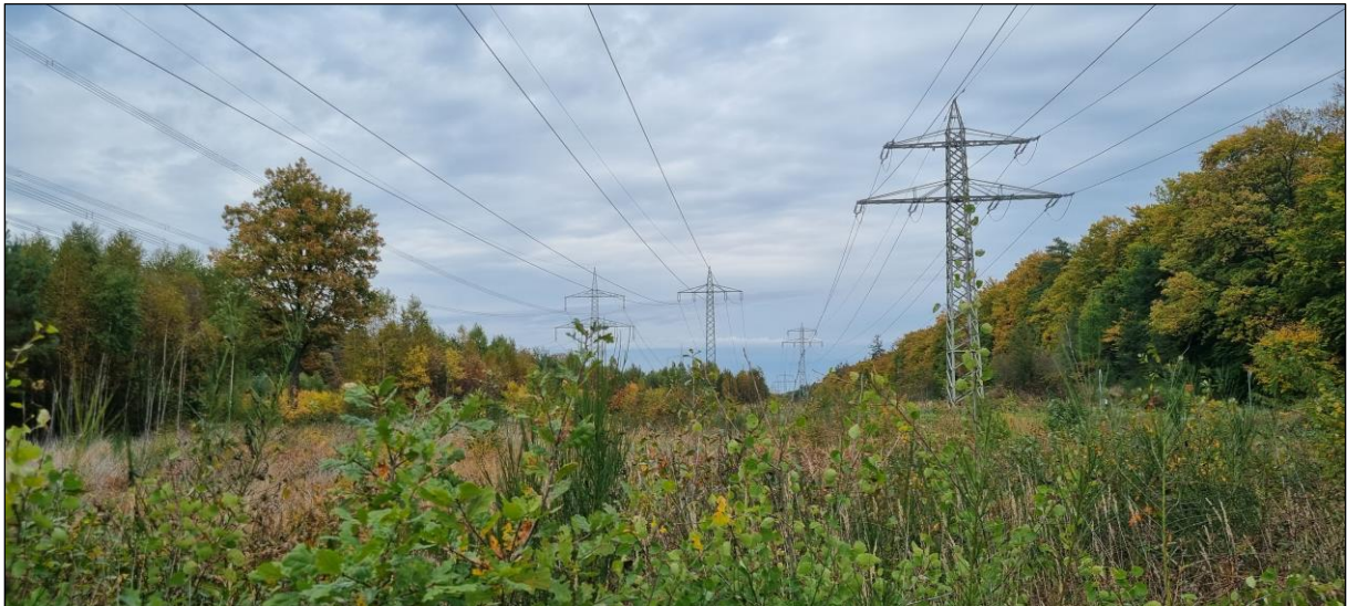
Abbildung 4: Lüßwald mit 380 kV-Bestandsleitung TrnneT, 110-kV-Bahnstromfernleitung Lehrte - Uelzen und 110-kV-Leitung Stadorf – Bostel der Avacon Netz GmbH (v.l.n.r).
