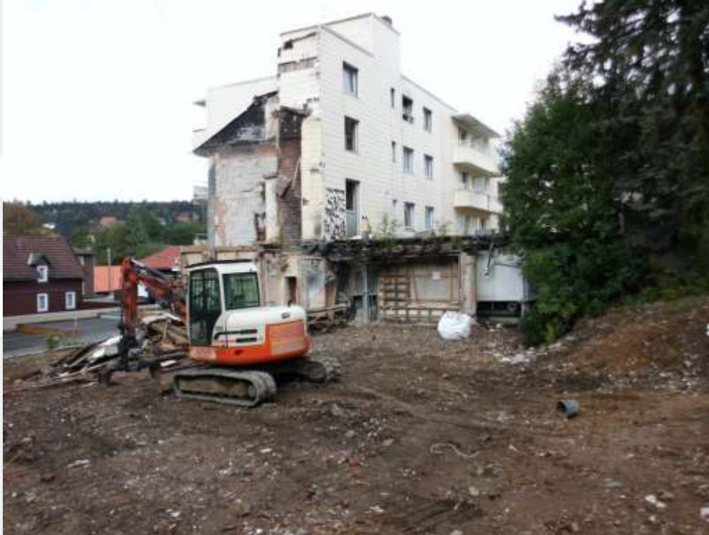
Ansicht des rückwärtigen Gebäudeteils mit verschlossenen Öffnungen
