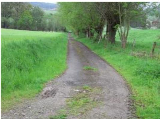
Dieser Wirtschaftsweg weist eine nicht tragfähige und schadhafte Bitu-Befestigung auf. Der Weg soll im Unterbau verstärkt werden und dann in Schotterbauweise ausgebaut werden (MSB-DoB).
