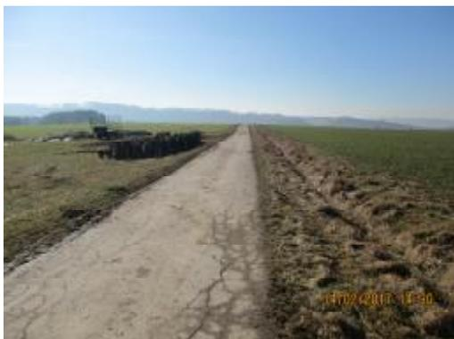
Verstärkung des nicht ausreichend tragfähig bituminös befestigten und teilweise beschädigten Wirtschaftsweges in bituminöser Befestigung.
