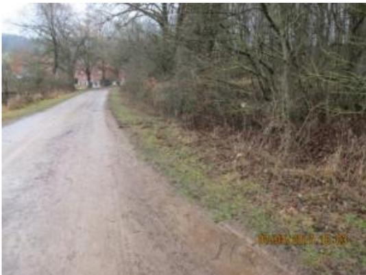
Der nicht mehr ausreichend tragfähige Schotterweg wird im Unterbau verstärkt. Ausbau in Schotter (MSB-DoB).
