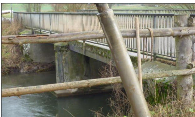
Bild 16: Wirtschaftswegbrücke E. Nr. 120.01 | Stand: Januar 2018
