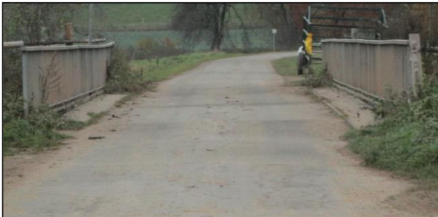
Bild 15: Wirtschaftswegbrücke E. Nr. 120.01 | Stand: November 2015
