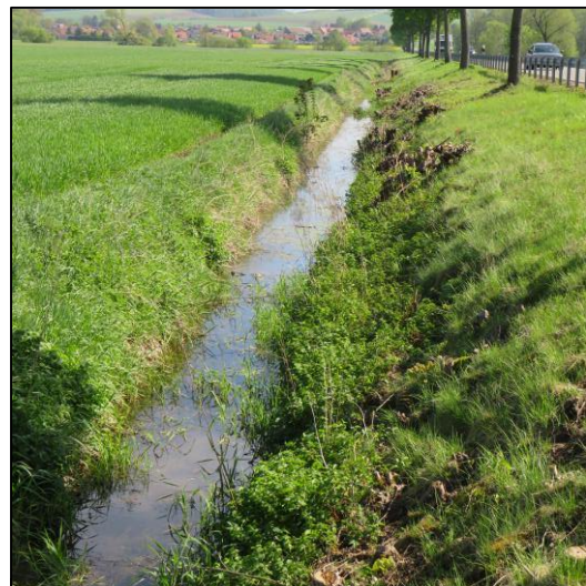
Bild 21: Entwässerungsgraben; E. Nr. 507 | Stand: April 2018
