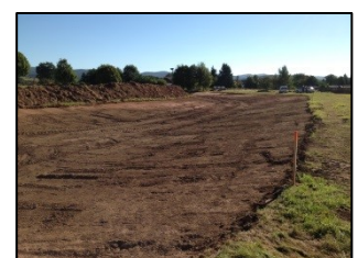
Anlage der Flutmulde
