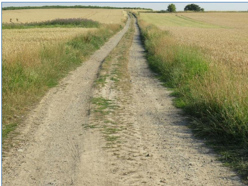
Das Bild mit Blickrichtung nach Norden vom südlichen Wege Ende aus zeigt die schlechte Verfassung des Weges deutlich auf. Die Deckschicht ist stark mit Erde vermischt und die Fahrspuren tief in den Weg eingearbeitet. Die Verbesserung der Befestigung ist dringend nötig.
