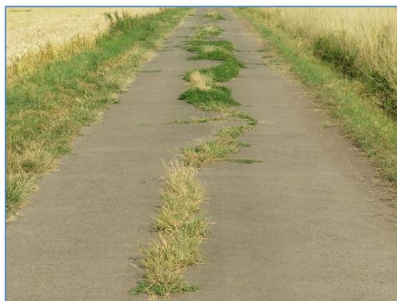
Aufgrund der relativ hohen Bedeutung des Weges für die Erschließung der nördlichen Feldmark ist die Bauweise der Betonspurbahn gewählt worden. Der Weg dient als Anbindung an
