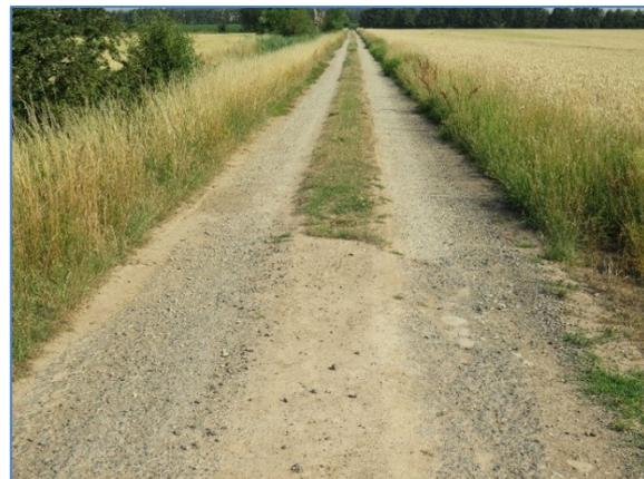
Übergangsbereich von der Bituminösen- zur Schotterdeckschicht; Blickrichtung Norden
