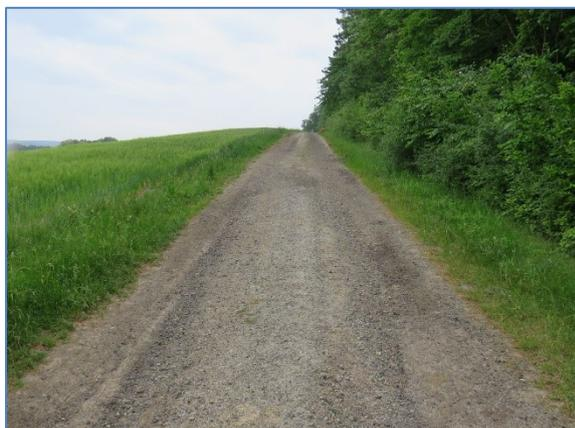
Dieser Abschnitt des Hauptwirtschaftsweges weist ein starkes Gefälle auf. Aufgrund dessen, ist hier die Ausbauphase als hydraulisch gebundene Deckschicht geplant.
