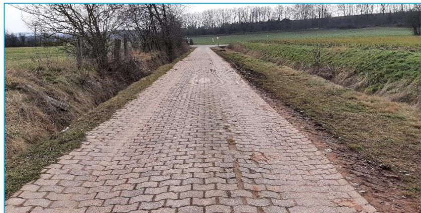
L 530 muss eine verkehrstechnisch gerechte Gestaltung stattfinden. Hierzu wird eine so genannte Trompete errichtet. Das Bild oben zeigt den aktuellen Zustand der Wartebergstraße. Es ist deutlich zu erkennen, dass sich starke Fahrspuren gebildet haben und vermehrt über die äußere Kante gefahren wird. Das Bild unten zeigt die Planung in der Karte zum P 41.
