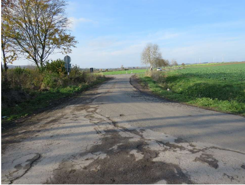
E.Nr. 103.10: Blickrichtung von Osten auf den Kreuzungsbereich zur K 6. Der jetzige Einmündungsbereich ist für Begegnungsverkehr zu schmal.
