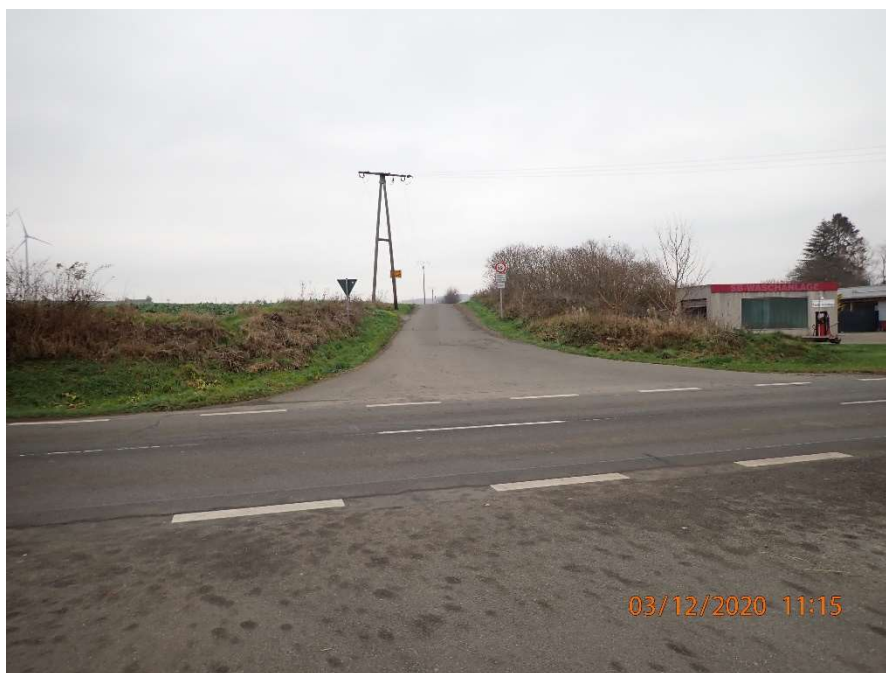
E.Nr. 119.30: Im Kreuzungsbereich zur K 6 fehlt die Verbreiterung um einen Begegnungsverkehr zu ermöglichen.
