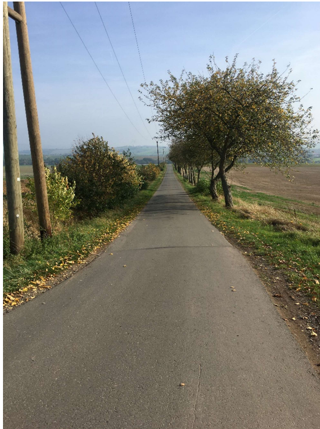
E.Nr. 119.10: Blickrichtung von Westen Richtung Osten. Durch die Baumreihe und den Wegeseitengraben auf der anderen Seite ist die Ausbaubreite recht schmal.
