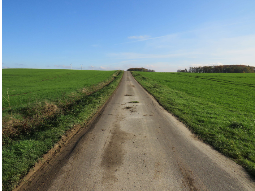
E.Nr. 729: Blick von E.Nr.104.20 Richtung Osten
