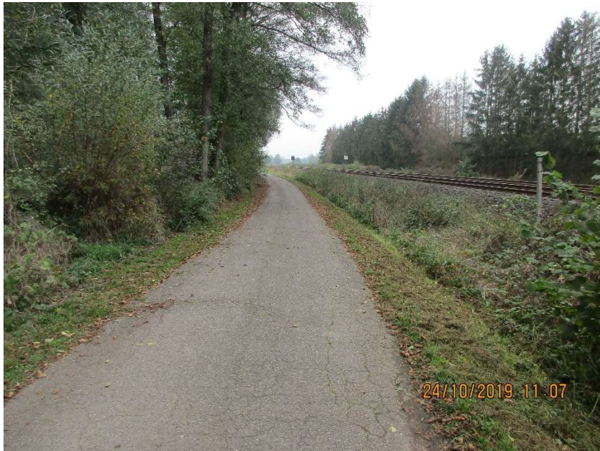
E.Nr. 106: Blickrichtung von Westen nach Osten am Ende der Baumaßnahme
