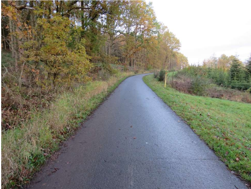
E.Nr. 200: Blickrichtung von E.Nr. 201.10 Richtung Westen.
