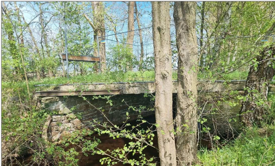
Abbildung 2: Ansicht Bestandsbauwerk [Ing.-Büro Hahn, GmbH, 2021]
