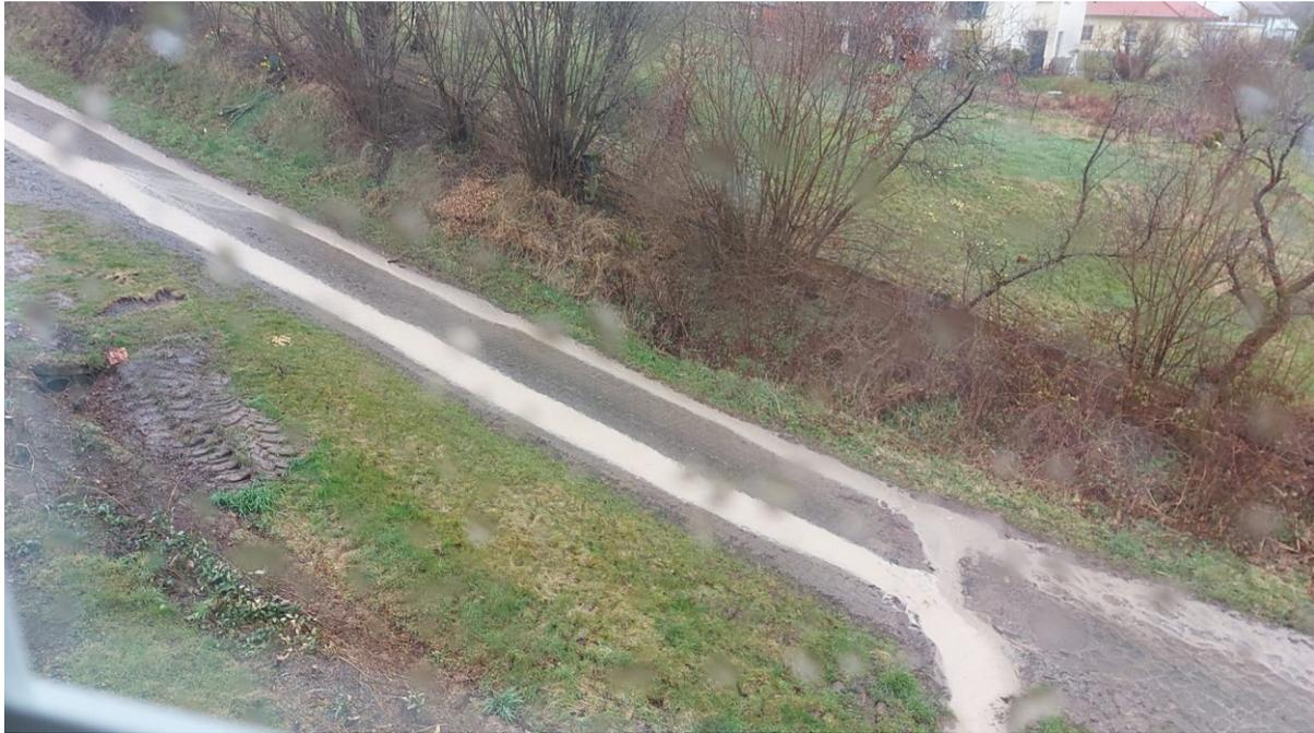
E.Nr. 121.10: Wassererosion durch ausgefahrene Spurrinnen auf dem Pflasterweg
